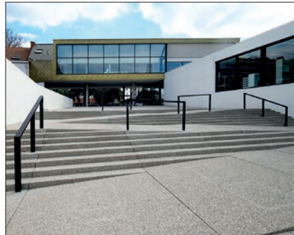
Figure 5.2 – Dalles coulées en une couche
