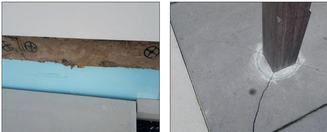
Figure 4.22 – Exemple de joint d'isolation et dégradation possible s'il n'y en a pas autour d'un point singulier
