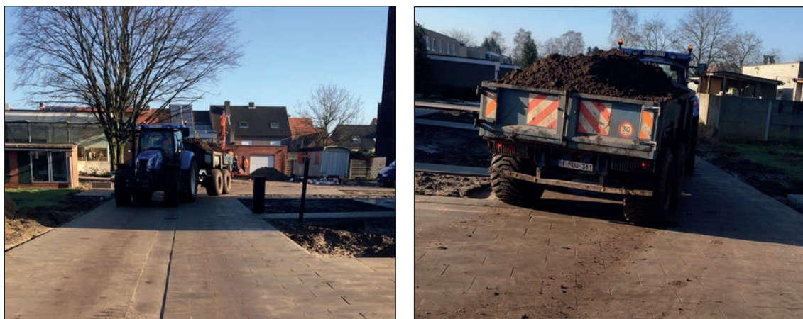
Figure 9.10 – Trafic lourd occasionnel constaté sur les dalles de la figure 9.8
