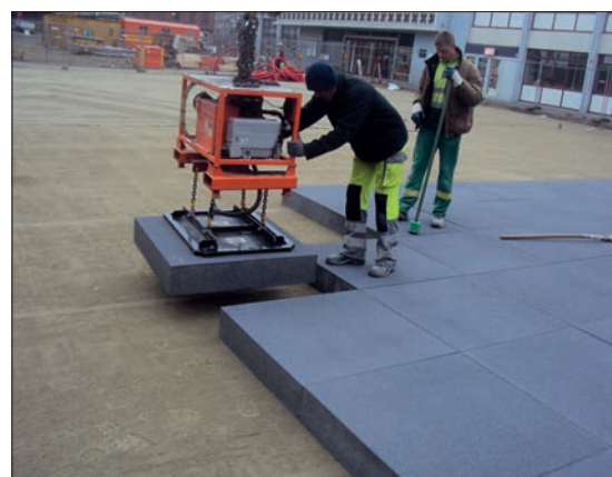
Figure 4.5 – Pose et mise en œuvre d'une couche de pose (nivelage avec une règle) pour des dalles de grand format
