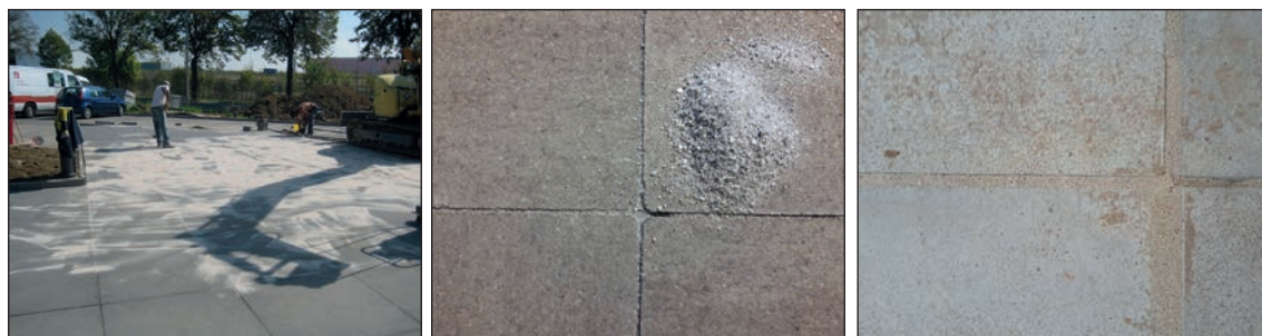
Figure 4.12 – Jointoiement avec le matériau approprié pour obtenir un remplissage complet des joints
