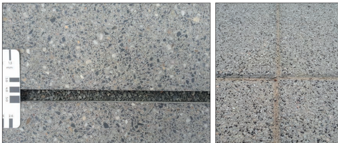
Figure 8.1 – Inspection régulière de l'état des joints
