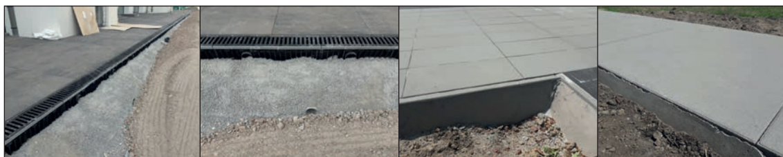
Figure 4.3 – Contrebutage et/ou épaulement correct en béton maigre
