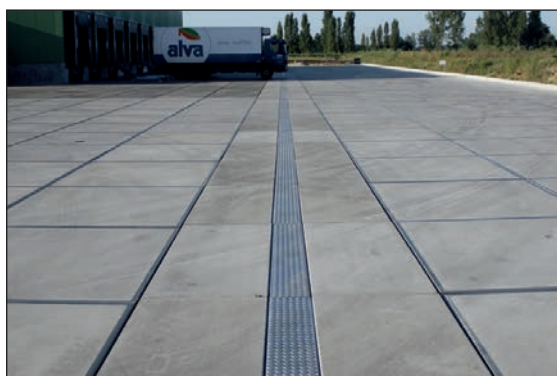
Figure 4.24 – Soins particuliers apportés à la finition des bords et autour des points singuliers, aux coupures au niveau des croisements et dans les courbes avec application d'un chanfrein, ainsi qu'à la finition des détails, avec utilisation éventuelle de formes spéciales
