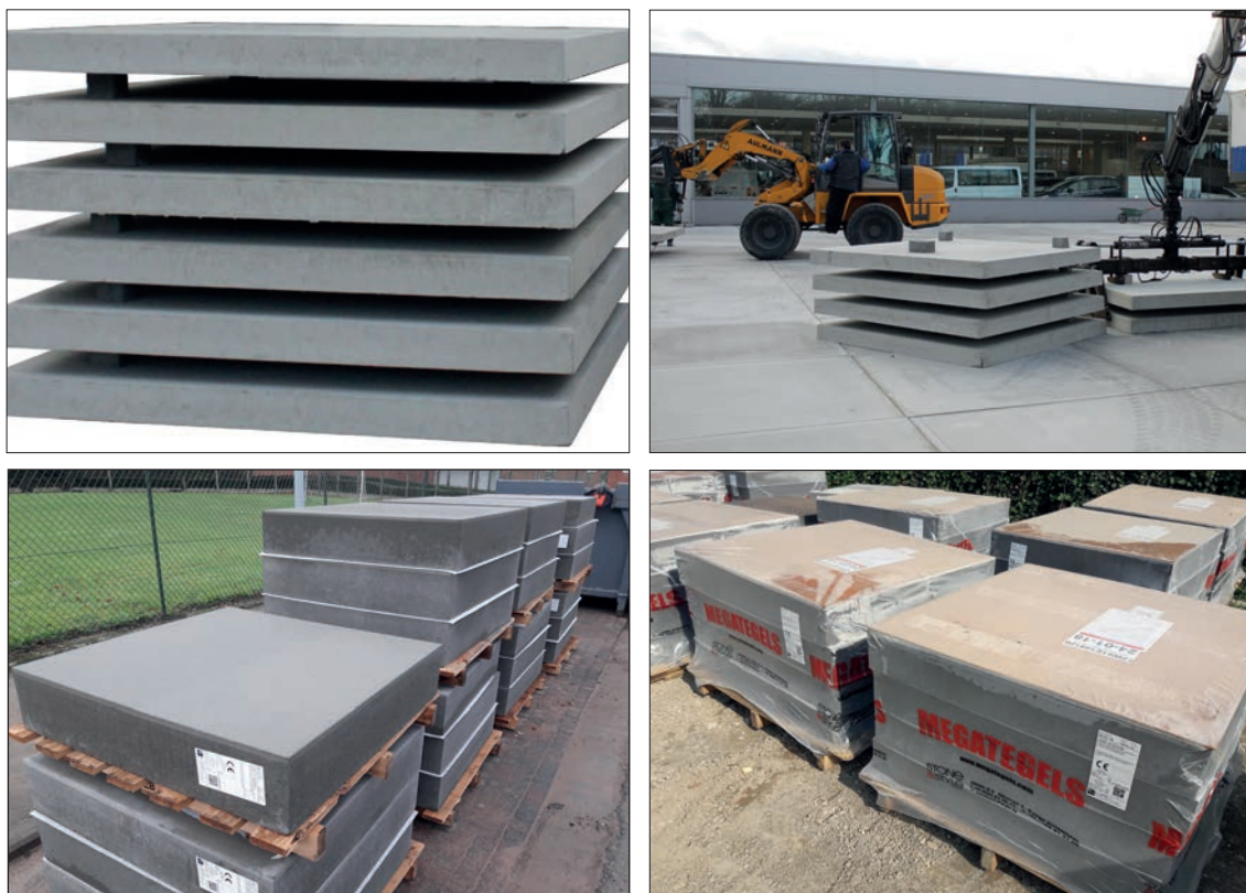
Figure 4.1 – Précautions lors du déchargement et de l'empilage des dalles préfabriquées et des dalles de grand format en béton
