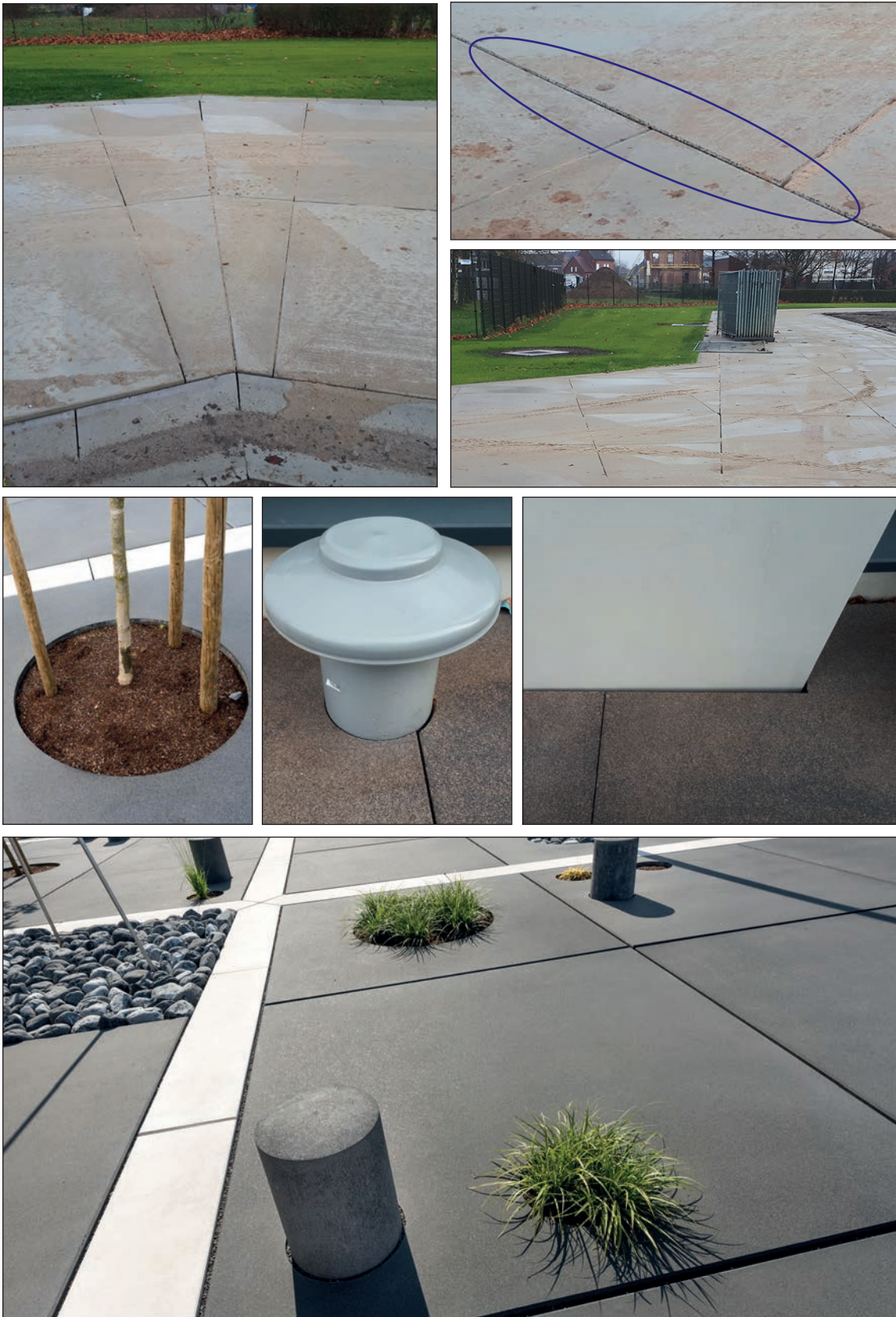
Figure 4.24 (suite) – Soins particuliers apportés à la finition des bords et autour des points singuliers, aux découpes au niveau des croisements et dans les courbes avec application d'un chanfrein, ainsi qu'à la finition des détails, avec utilisation éventuelle de formes spéciales.
