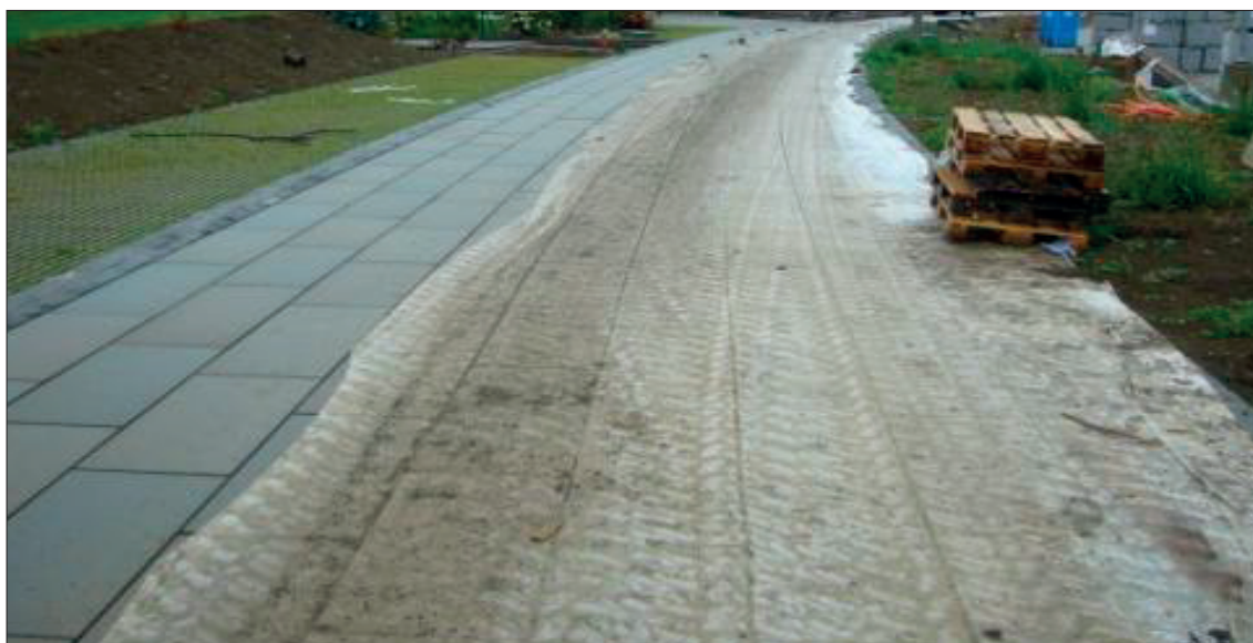
Figure 4.10 – Protection de dalles de grand format avec un géotextile pour éviter toute salissure pendant la pose
