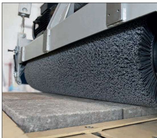
Figure 5.18 – Brossage de la surface en béton
