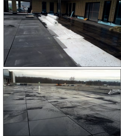
Figure 7.7 – Exemple d'une réalisation sur couche de pose en empierrement 2/6,3
