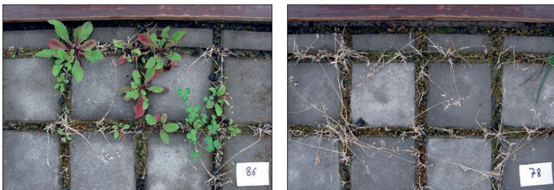
Couche de pose fermée (calcaire 0/6,3)
