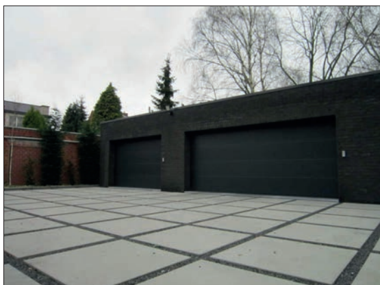
Figure 7.1 – Largeurs de joints à respecter pour un pourcentage de joint \geq 10\% avec des dalles de grand format et exemples d'applications
