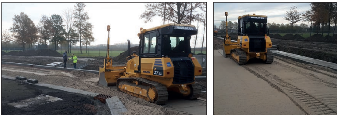
Figure 4.6 – Précompactage pour dalles préfabriquées en béton par le passage régulier de machines pendant l'épandage (en avant) et le profilage (en arrière) de la couche de pose
