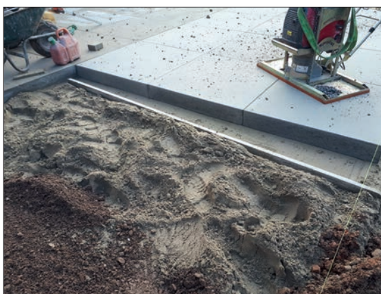
Figure 4.5 – Pose et mise en œuvre d'une couche de pose (nivelage avec une règle) pour des dalles de grand format
