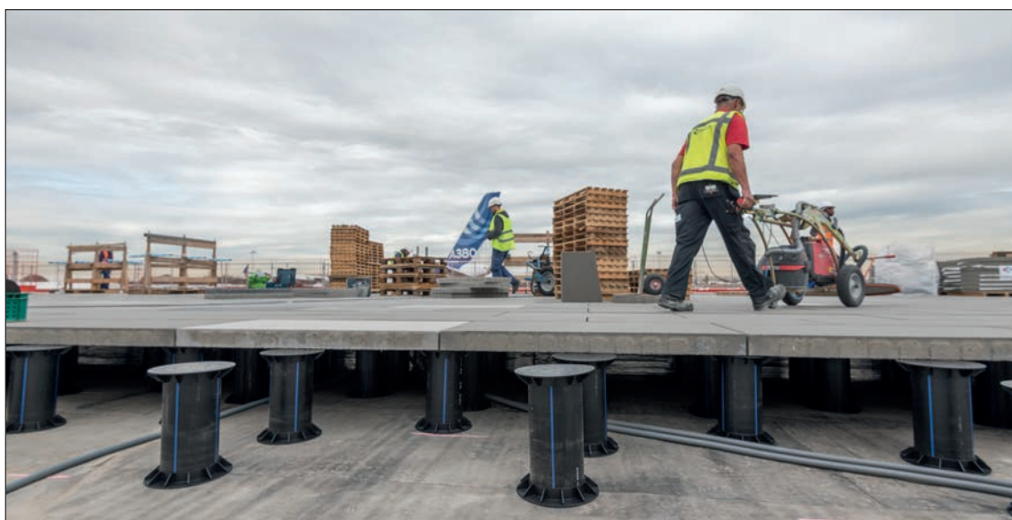
Figure 7.5 – Pose de dalle sur plots
