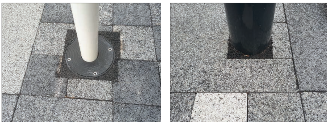
Figure 8.6 – Application de matériaux innovants dans des ouvertures plus larges autour d'obstacles
